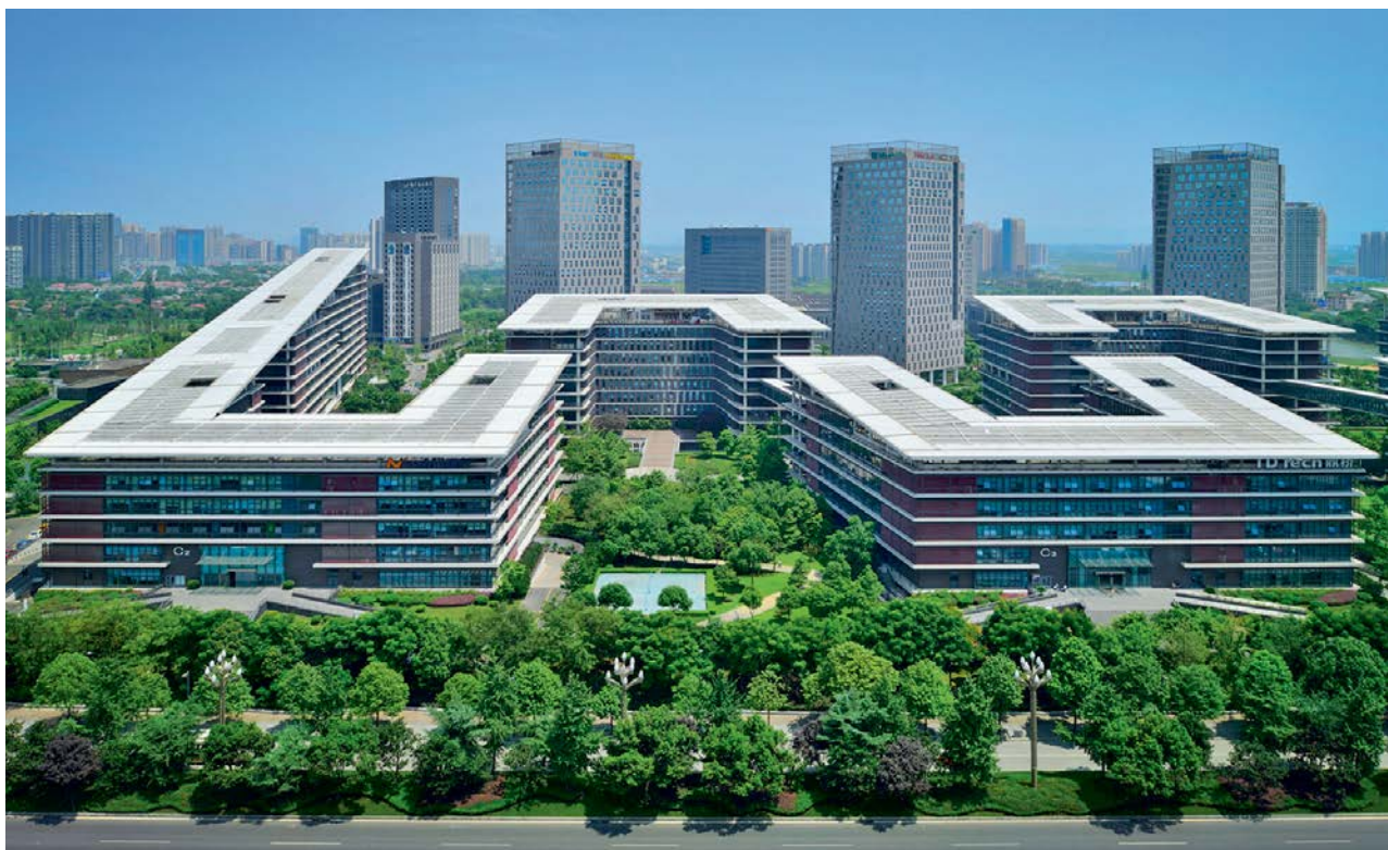
Aparte de oficinas, el Chengdu Tianfu Software Park incluye edificios residenciales, cafés, restaurantes y tiendas, y hasta parques.
