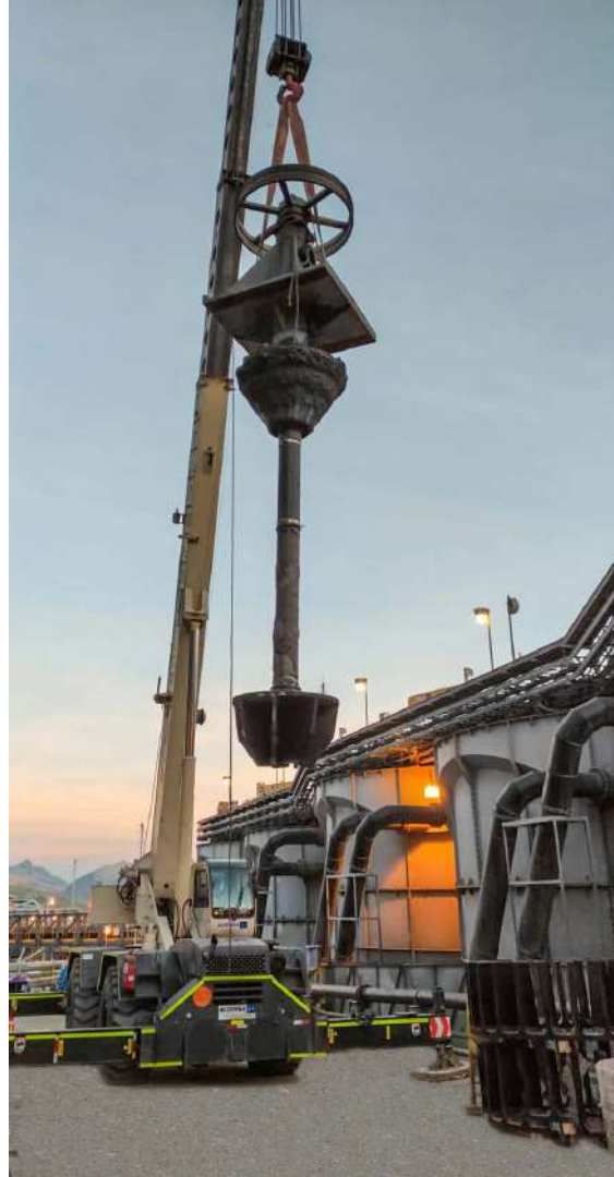
Parada de planta (programa de mantenimiento) en Chinalco.
