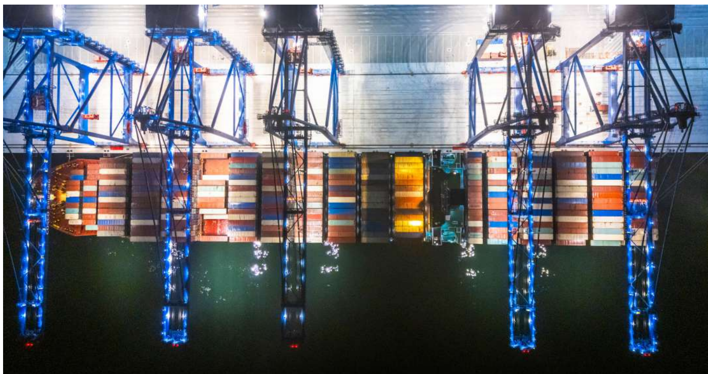
El muelle principal tiene una profundidad de 17.8 metros y permite el atraque de los buques de carga más grandes del mundo.
